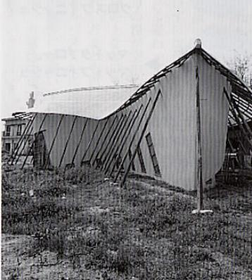
ゲストハウス1の基本構造は3本の柱と土壁。その上に波板で造られた屋根が乗っている。
